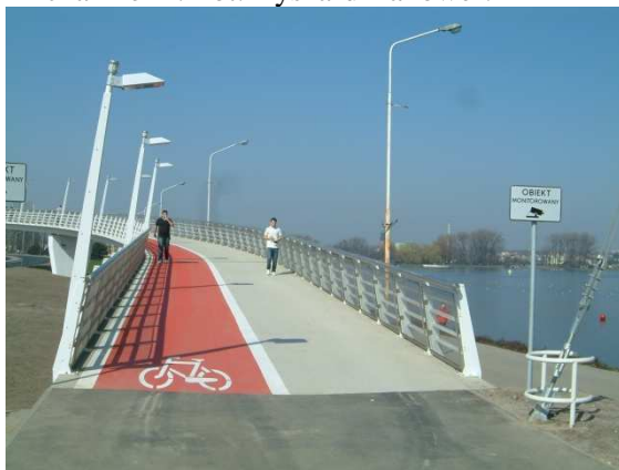
Kładka pieszo-rowerowa ułatwiająca dojście do centrum handlowego Galeria Malta w Poznaniu. Fot. Michał Beim.
