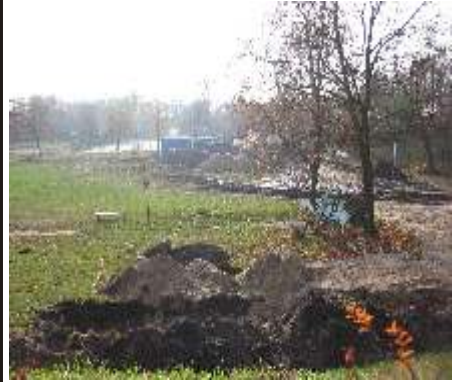
Nasz Orlik w trakcie budowy
